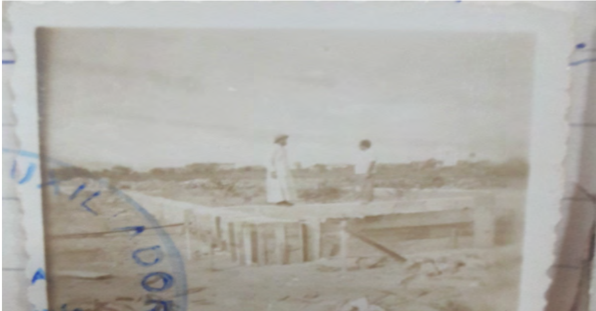
Fotografia1: Construção inicial da Igreja Nossa Senhora Auxiliadora de Vilhena/RO
